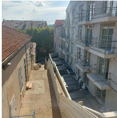
Vue du chantier vis-à-vis de l'école Chabaud en septembre 2022
