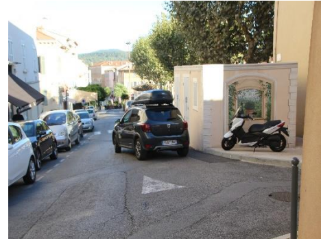
Le transformateur de la Place de la République ne permet plus la circulation à double sens sur une voie où elle est pourtant autorisée
