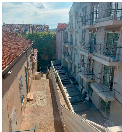
Vue du chantier vis-à-vis de l'école Chabaud en septembre 2022
