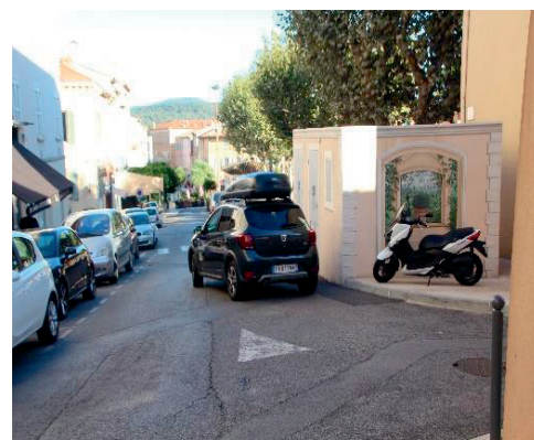
Le transformateur de la Place de la République ne permet plus la circulation à double sens sur une voie où elle est pourtant autorisée
